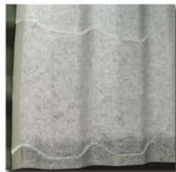
Antikondens-Beschichtung mit Versiegelung bei der Überlappung und nicht beschichtetem Längsstoß
